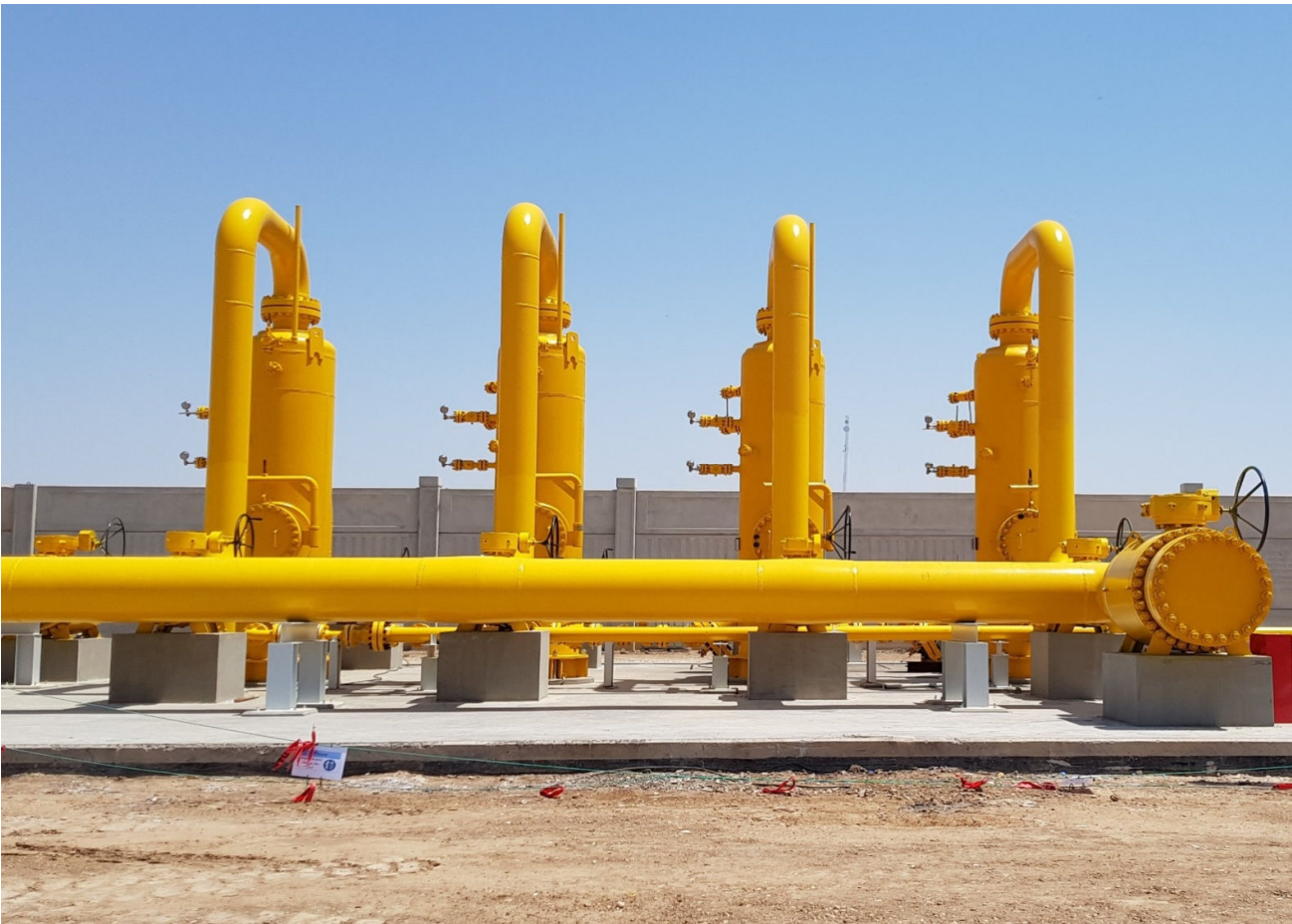
اسکرا برها و استرینرهای گاز نیروگاه بسمایه بغداد - عراق
