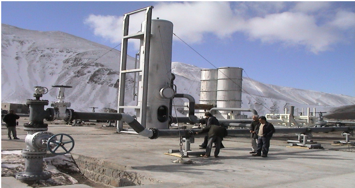
تجهیزات سر چاهی نیروگاه انرژی زمین گرمایی مشکین شهر (Separator, Piping, Cooling tower, silencer) به همراه کلیه شیرآلات و ابزار دقیق به کارفرمایی سازمان انرژی های نو ایران (سانا)
